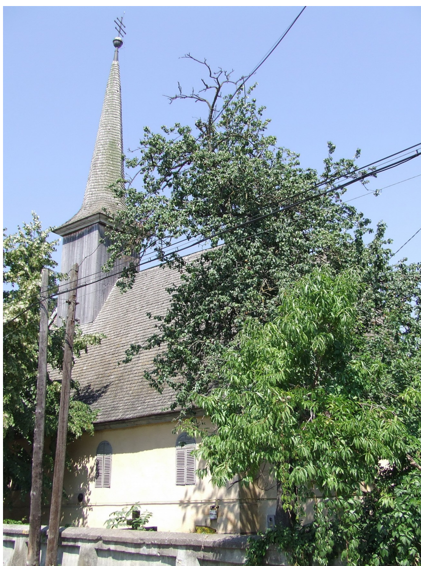
Fațada sudică, unde se vede ritmul ferestrelor neoclasiche, cu obloane. Foto: Bogdan Ilieș, WIKIPEDIA
