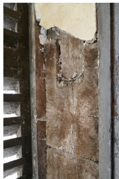
Ușorul ferestrei originale a bisericii din Șomcuta Mare și bârnele tăiate pentru mărirea golului ferestrei.
